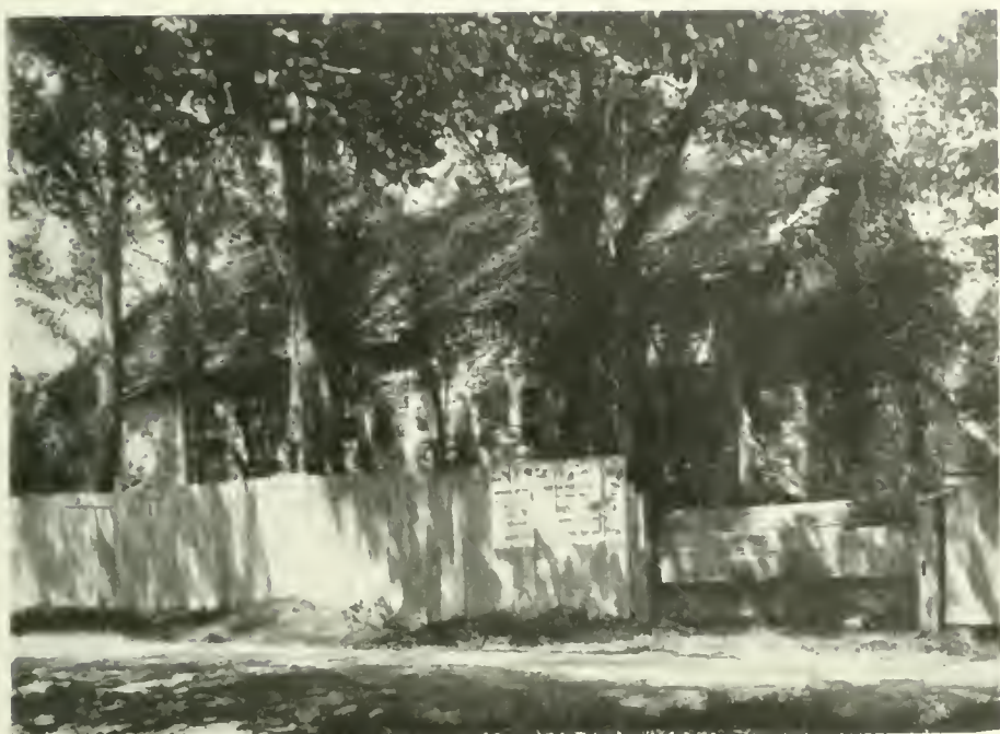
MAISON DE RENÉ ROBERT CAVELIER DE LA SALLE A MONTRÉAL. Cliché de la Société de Géographie.
